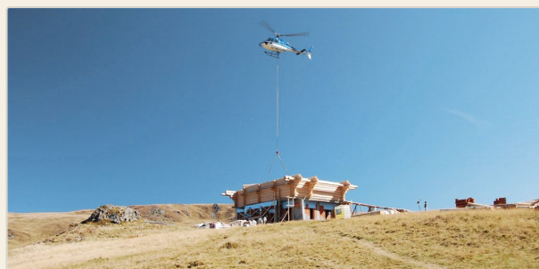
MONTAJ ÎN ZONE MONTANE • TRANSPORT CU ELICOPTERUL
