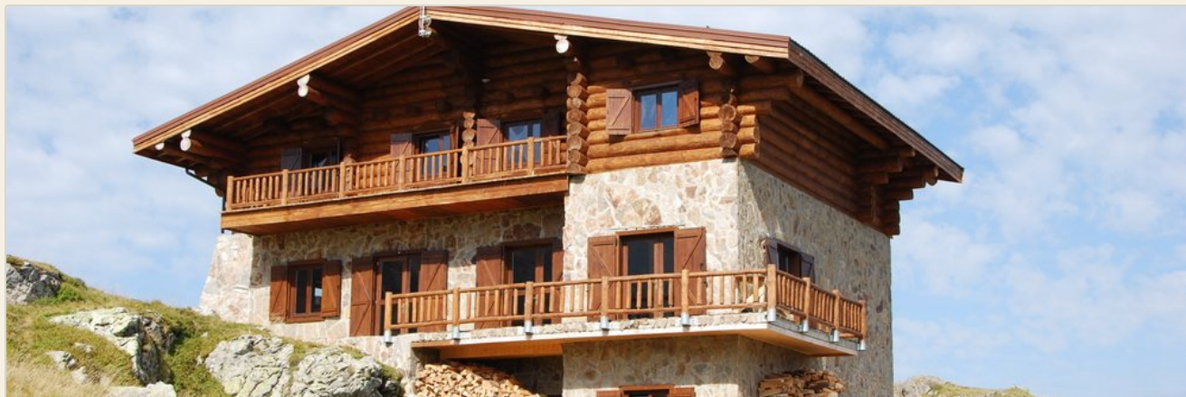
CASE DIN LEMN MASIV ROTUND · ÎMBINARE ÎN TEHNICĂ CANADIANĂ
